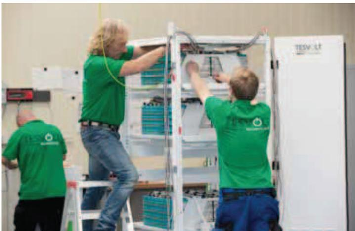
Gewerbe- und Großspeicher sind in der Regel modular aufgebaut und werden für einzelne Projekte zusammengestellt.
