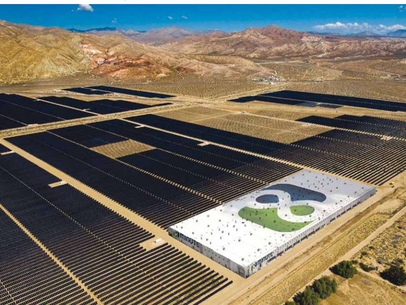
So soll das Solar-Speicher-Hybridkraftwerk einmal aussehen.
